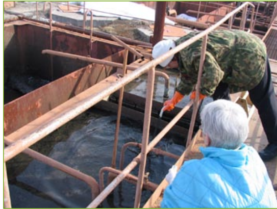
Очистные сооружения Кольской АЭС
