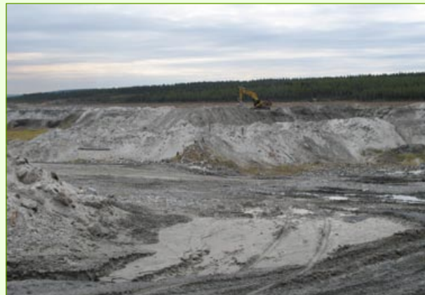
Первое поле хвостохранилища Ковдорского ГОК – техногенное месторождение бадделлит-апатитовых песков
