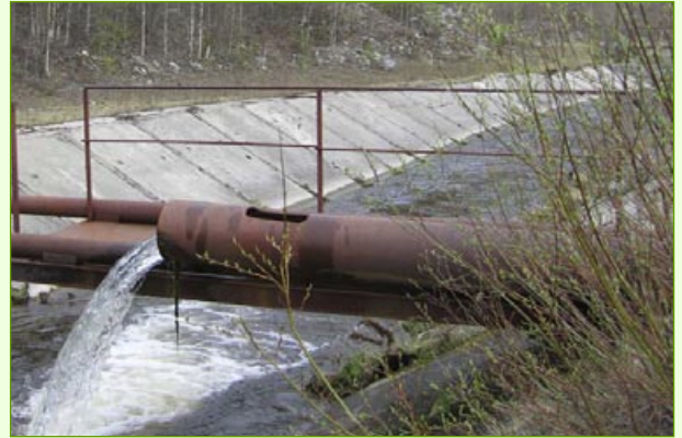
Сброс сточных вод Ковдорского ГОК от водопонизительной системы в канал р. В. Ковдора
